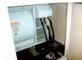
写真1(c) 非常用発電機のジェネレーター
