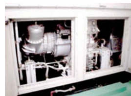
写真1(b) 非常用発電機のジェットエンジン
